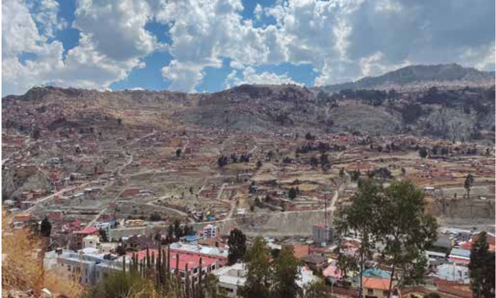
Figura 5 Asentamientos urbanos en lo que fue un megadeslizamiento de Callapa, La Paz
